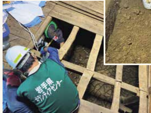
災害ボランティア活動(床下の泥のかき出し)の様子
